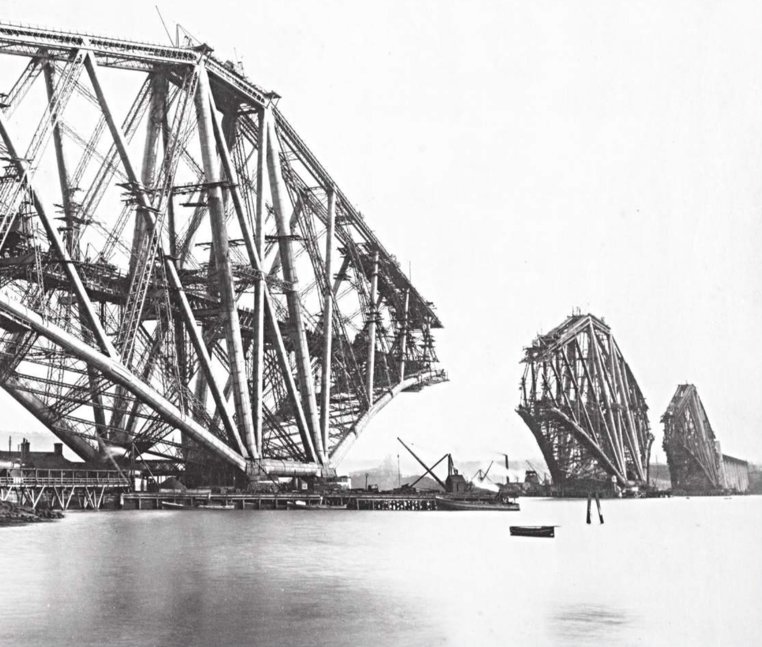
Die größte Brücke ihrer Art: Tausende Arbeiter errichten 1889 ein Geflecht aus Stahlröhren über den Fluss Forth nahe Edinburgh, 58 000 Tonnen schwer. Der mittlere Pfeiler der 2,5 Kilometer langen Konstruktion ruht auf einer Felseninsel im Wasser. Als die Forth Bridge im Jahr darauf vollendet wird, gilt sie als eines der modernsten Bauwerke ihrer Zeit ●
