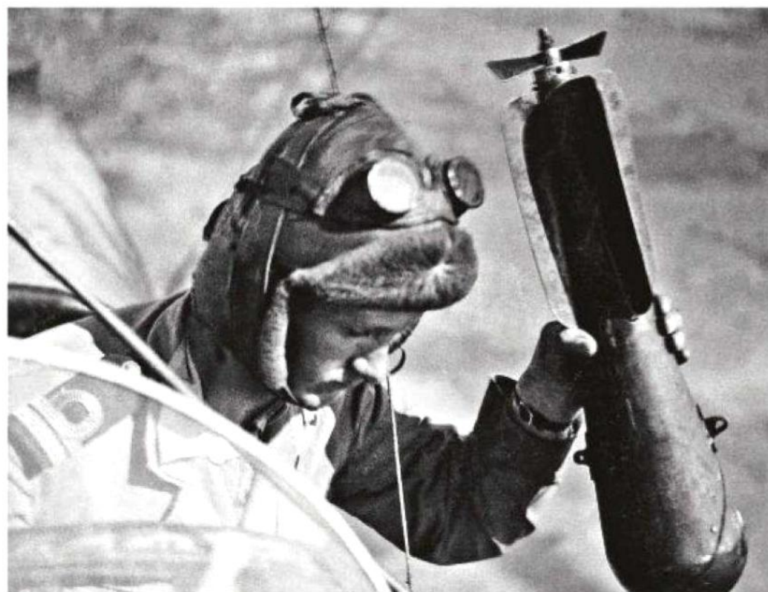
Zunächst werfen Flieger Granaten noch mit der Hand ab. Doch bald werden Haltevorrichtungen entwickelt, an die sich zentnerschwere Bomben montieren lassen
