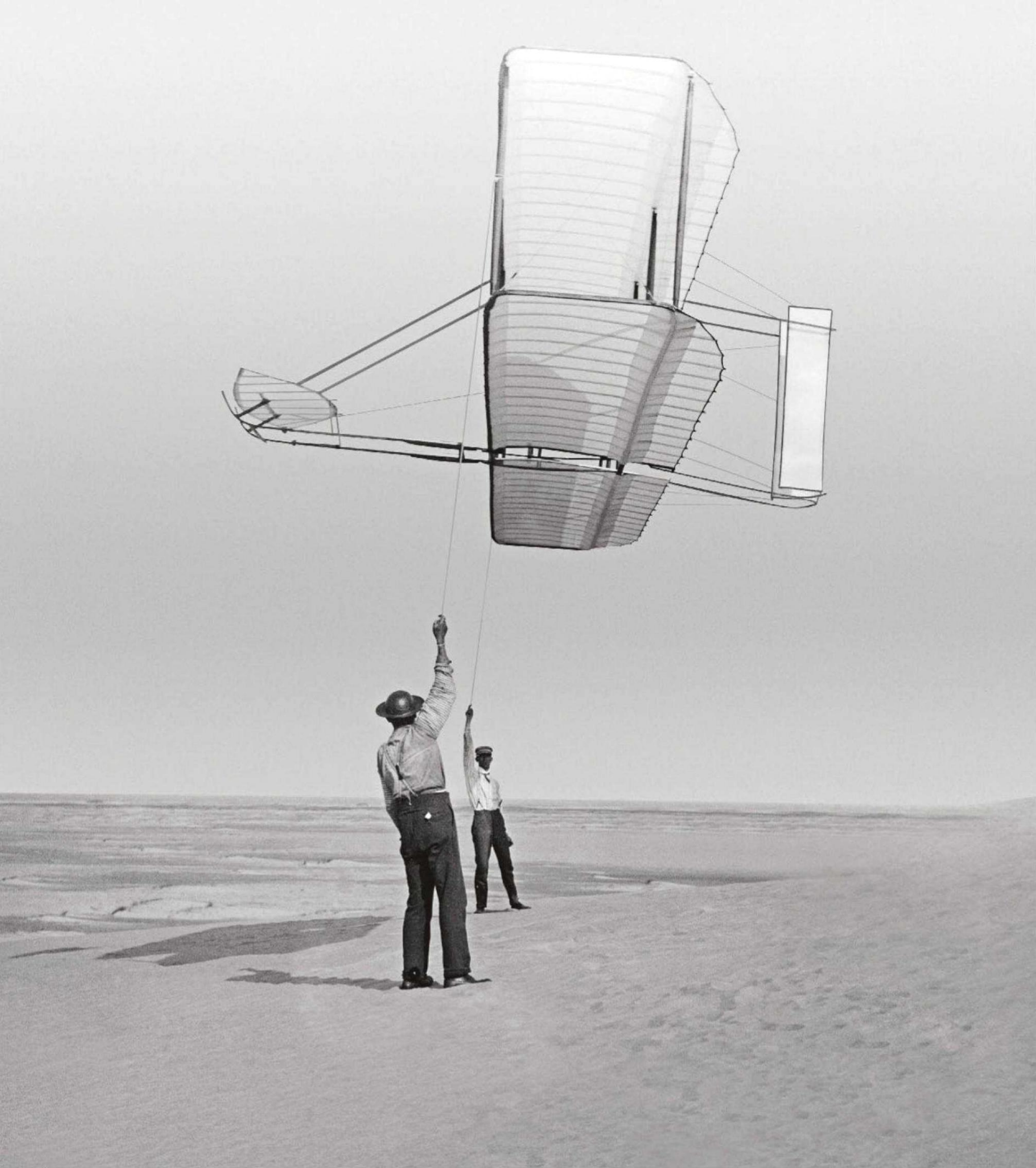
Wilbur (hinten) und ein Assistent lassen einen Gleiter wie einen Drachen steigen – und testen so Aerodynamik und Balance des Fluggeräts (1902)
