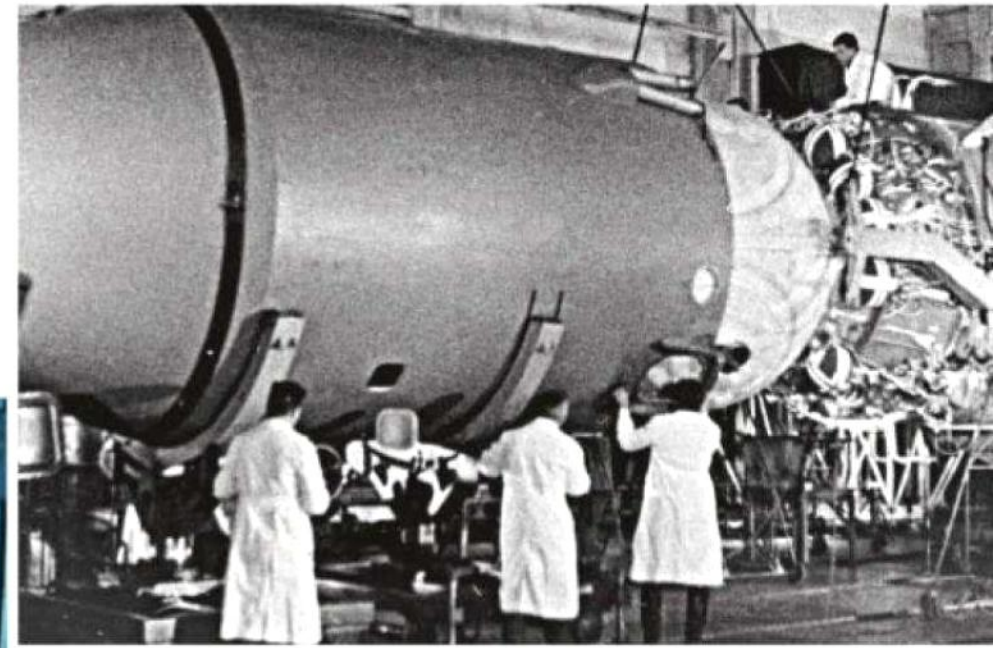
Dem Raumschiff, hier die Montage der Raketenspitze, geben die Russen den Namen »Wostok«: Osten
