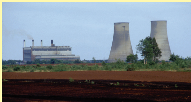
Erstes irisches Torfkraftwerk bei Ferbane (1957-2001)
