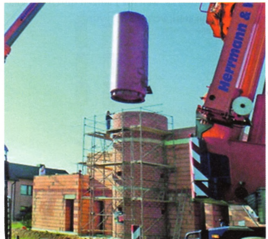
3.5.13: Einbau eines Ganzjahresspeichers in ein Sonnenhaus Quelle: Frankenpost, 2.8.2010.
