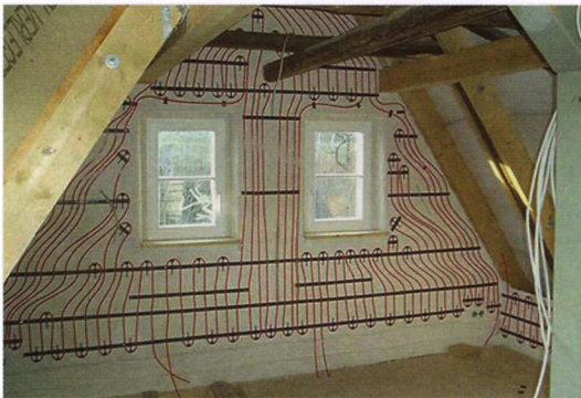
4.3.4: Wandheizung im Altbau-Dachgeschoss. Foto: Samuel Jenichen
