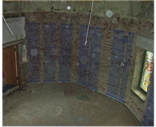
4.3.5: Wandheizung mit Kapillarrohrmatten.
