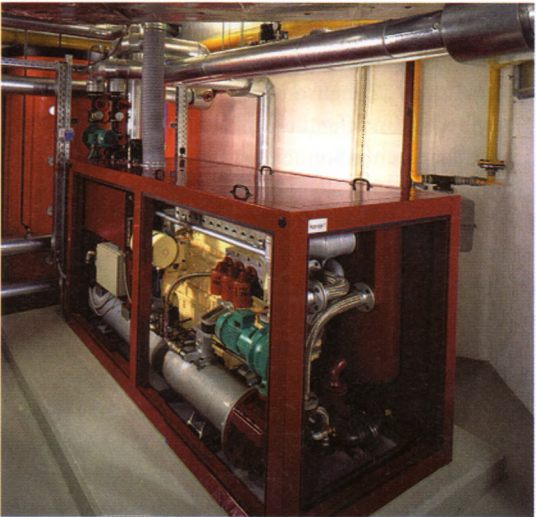
3.6.4 BHKW mit Gas-Otto-Motor mit 112 kW el elektrischer Leistung. Quelle: Fa. Comuna-Metall
