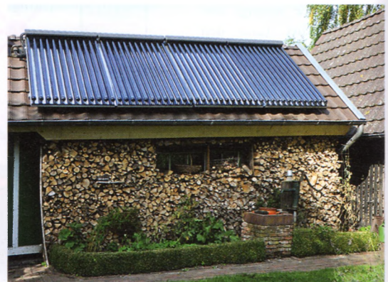
3.5.2 Röhrenkollektoren auf einem Schuppen für die Beheizung und Warmwasserbereitung eines EFH.
