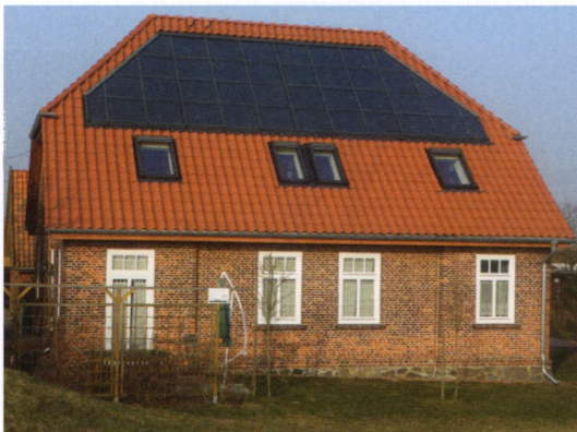
3.5.1 Solardach mit Flachkollektoren für die Beheizung und Warmwasserbereitung eines EFH mit Ferienwohnungen.
