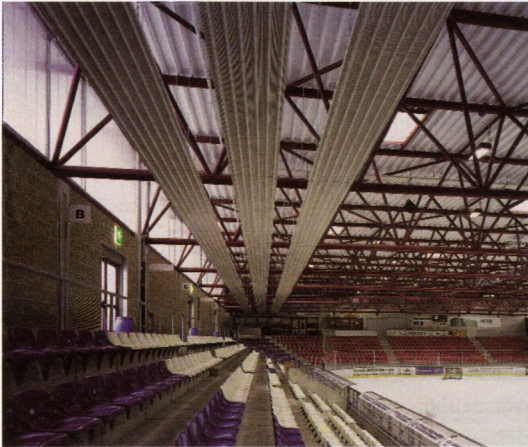
4.2.6: Deckenstrahlplatte der Firma Zehnder.
