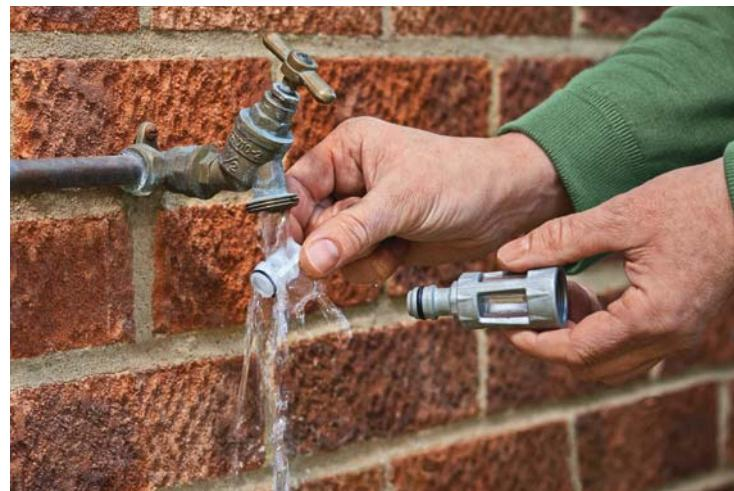
Reinigen des Wasserfilters.
