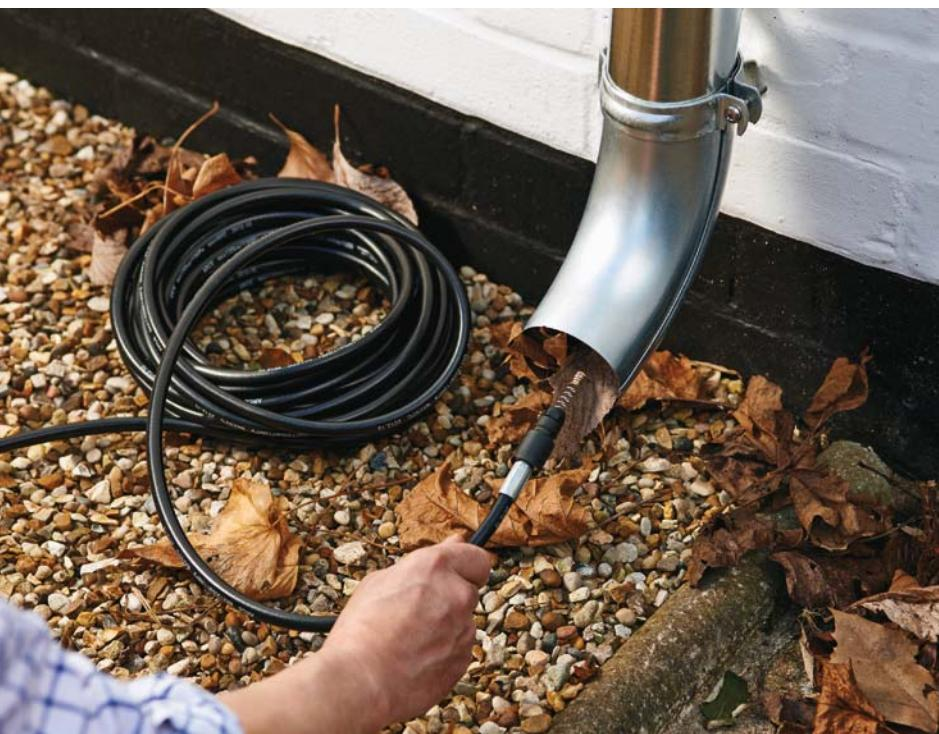
Bei Fallrohren arbeitet man von unten nach oben.
