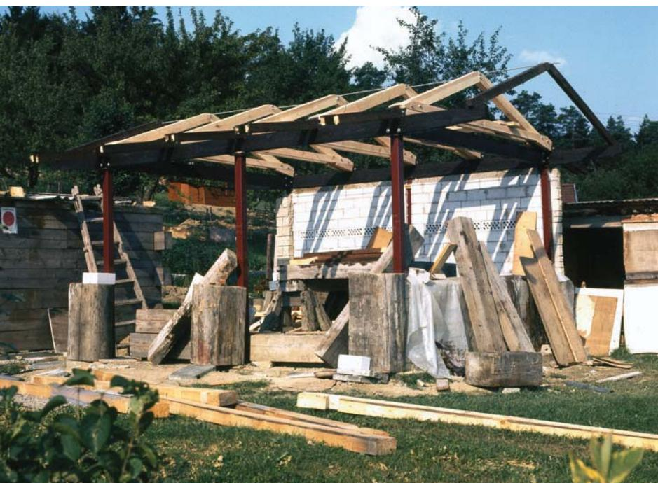
Dachstühle werden oft in einer Kombination aus klassischen Verbindungstechniken und Nägeln oder Schrauben hergestellt.
