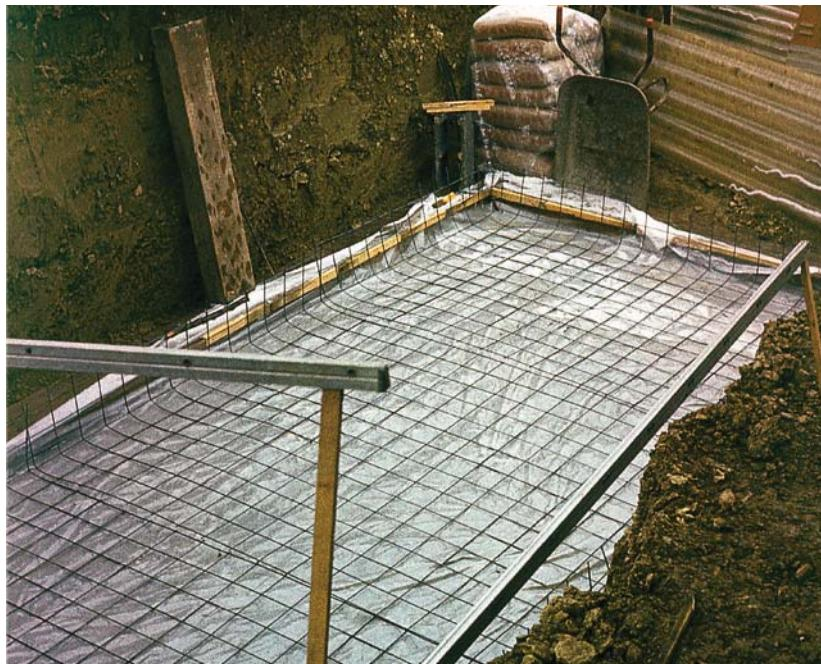
**Stahlbeton wird mit einer Bewehrung aus Moniereisen versehen.**
