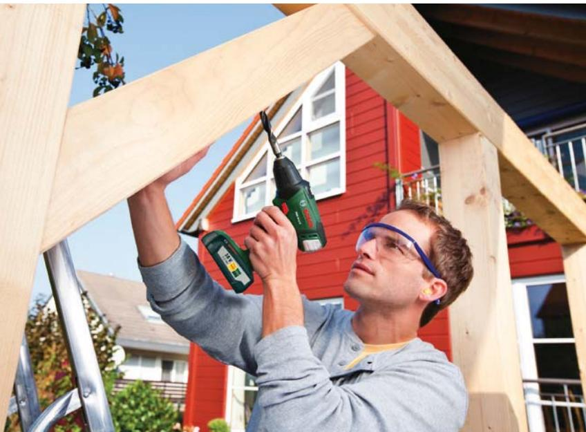
Bohren mit dem 14,4-V-Bohrschrauber.
