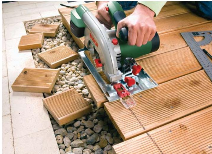
Die Kreissäge ist zum Ablängen eines Terrassenbelags sehr gut geeignet.
