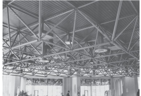
Bild 6.12: Mensa der Universität Kaiserslautern, Tetraeder-Halboctaeder-Packung
