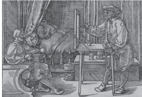
Bild 13.5: Perspektivmaschine mit Visier, Holzschnitt, 1525, Albrecht Dürer
