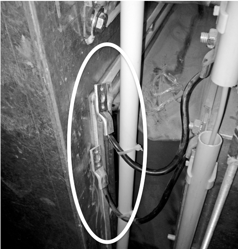
Abb. 5.28 Nicht funktionsfähiger Potentialausgleich (Quelle: eigenes Foto)
