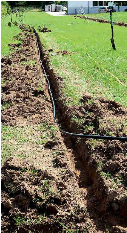
Unterflur. Bis auf das System von Kärcher verlaufen die Zuleitungen im Boden. Das heißt: buddeln.
