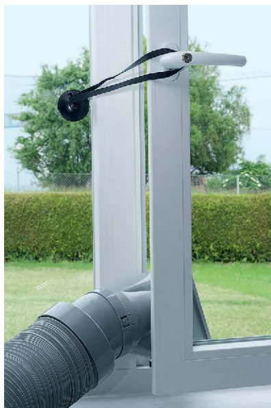
Undicht. Die Abluftschläuche der Monoblöcke hängen aus dem Fenster. Warme Luft strömt nach.
