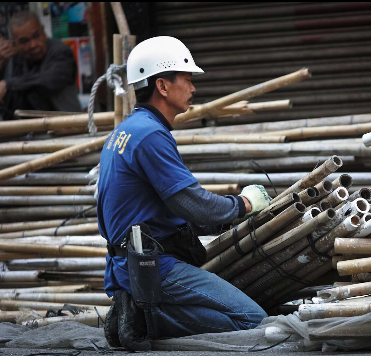
♣ Gerüstarbeiter · Mit riesigen Gerüsten aus Bambus werden in China ganze Hochhäuser gebaut. Sie werden nur mit Hanfseilen zusammengebunden. Aluminiumgerüste, wie sie in Europa üblich sind, findet man eher selten. 147 mm · ISO 400 · f 2,8 · 1/320 Sek
