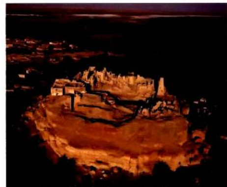
Rettung durch Stahlstreben im Berg: der Orakeltempel der Oase Siwa, der abzukippen drohte. Aufgestiegenes Wasser ließ Tonschichten aufquellen, was den Hügel hätte zersprengen können
