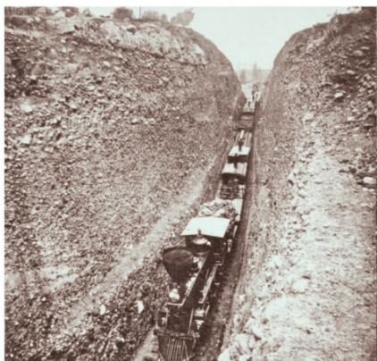
In Kalifornien schlagen meist chinesische Bauleute eine fast 250 Meter lange und knapp 20 Meter tiefe Schiene in das Gestein
