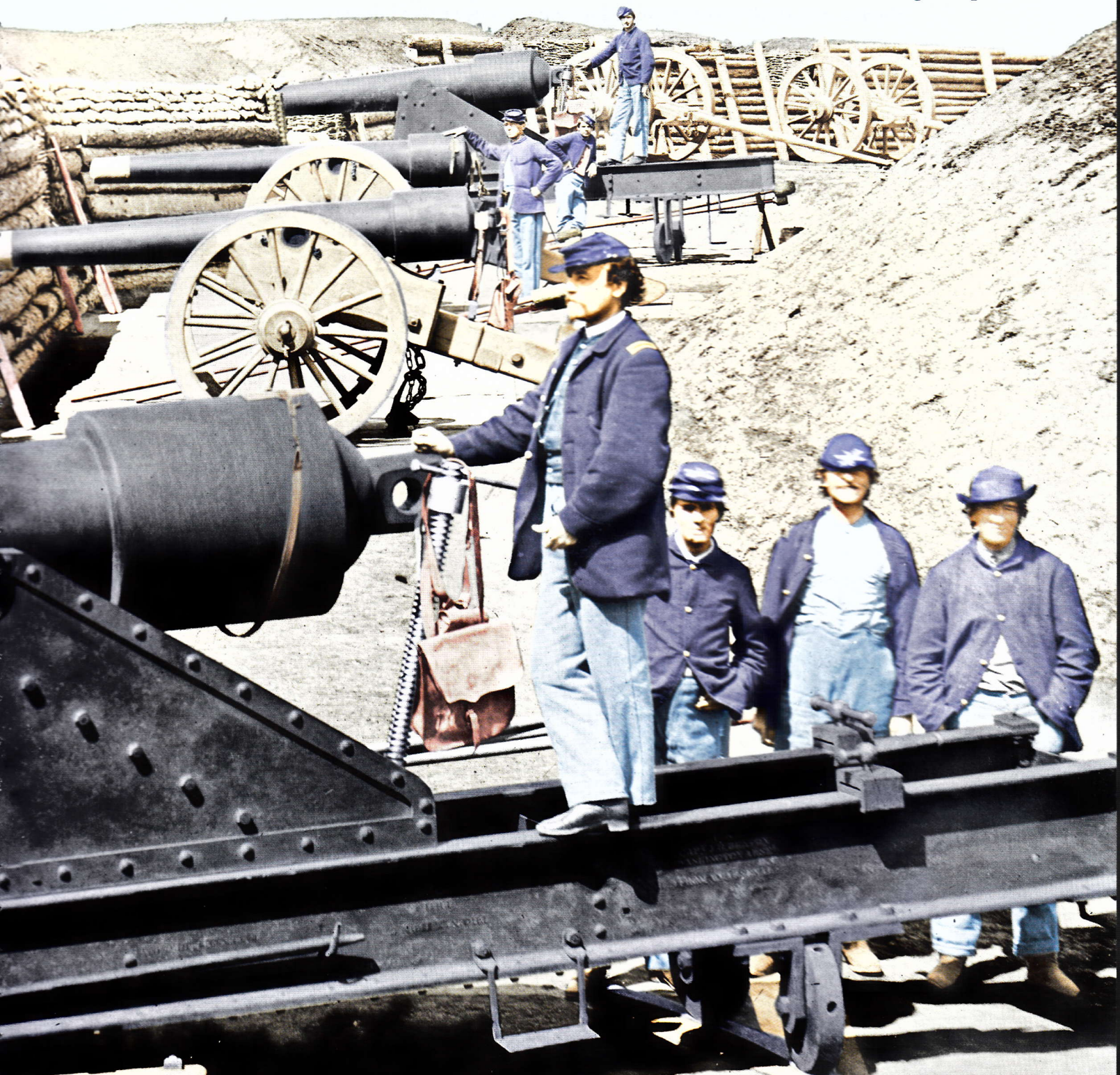
Eine Batterie in Fort Brady, Virginia. Fünf Männer sind nötig, um diese Kanone abzufeuern. Ihr Lauf ist geriffelt, sie schießt nicht mehr Kugeln, sondern längliche Projektile (links unten im Bild). Dadurch zielen diese Waffen weiter und genauer – und sorgen für verheerende Verluste unter den Angreifern
