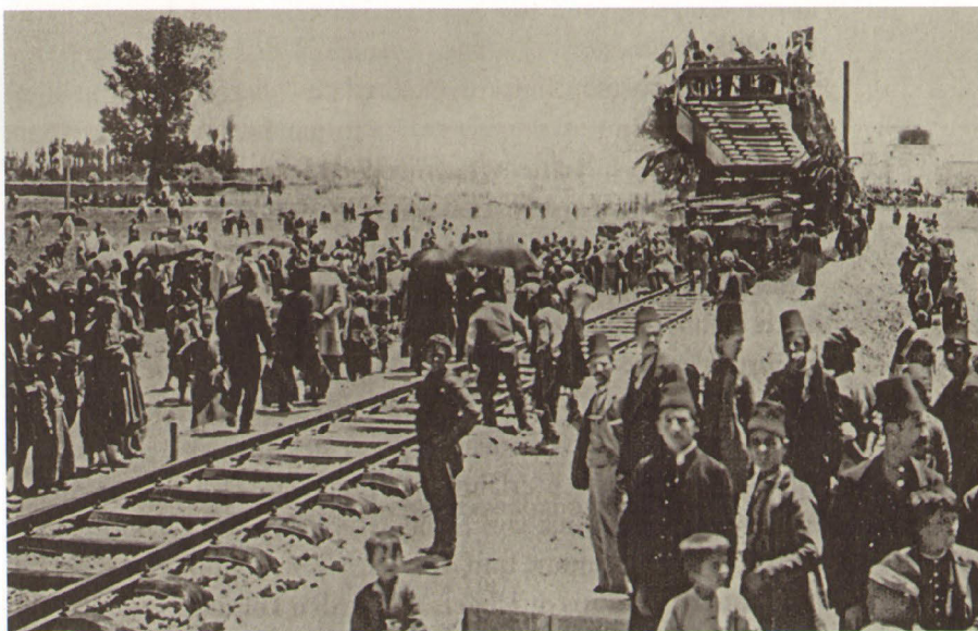
Für den Bau der Anatolischen Eisenbahn, die Istanbul mit Konya verbindet, konstruieren deutsche Ingenieure eine Gleislegemaschine (oben)
