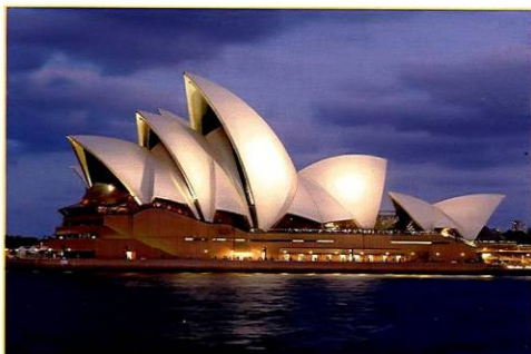
Nie zuvor sind so aufwendige Konstruktionen aus Beton errichtet worden: Das Dach über den Sälen des Opernhouses besteht aus acht bis zu 49 Meter hohen Halbschalen
