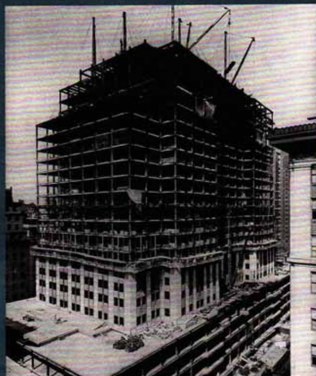
Der stufenförmige Bau an der Fifth Avenue wächst in Rekordtempo empor: Drehkräne wuchten die Stahlträger bis auf die oberste Etage, wo Männer Nieten in das Skelett treiben. Der Fotograf Lewis Hine hält die Arbeiten in schwindelnder Höhe im Auftrag der Bauherren fest – ein Teil von deren PR-Strategie
