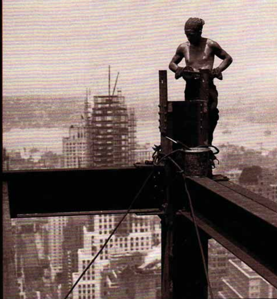
Der stufenförmige Bau an der Fifth Avenue wächst in Rekordtempo empor: Drehkräne wuchten die Stahlträger bis auf die oberste Etage, wo Männer Nieten in das Skelett treiben. Der Fotograf Lewis Hine hält die Arbeiten in schwindelnder Höhe im Auftrag der Bauherren fest – ein Teil von deren PR-Strategie
