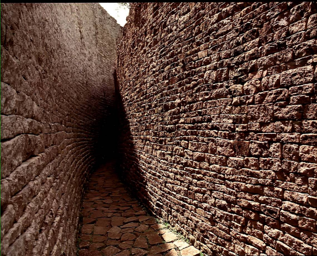
Bis zu elf Meter hoch schichten die Arbeiter in Groß-Simbabwe Granitblöcke aufeinander; die Mauern halten ohne Mörtel zusammen
