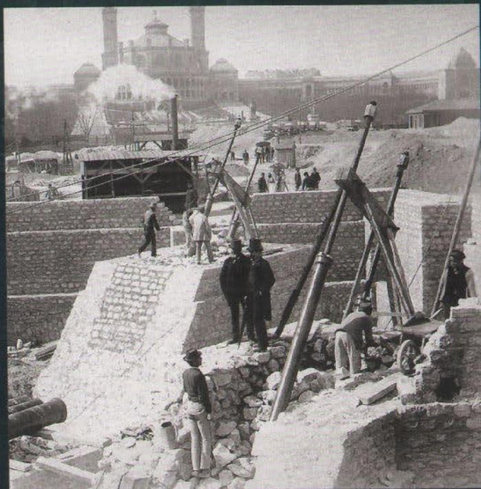
Um das Gewicht des Turms von gut 10 000 Tonnen zu tragen, lässt der Ingenieur und Unternehmer Gustave Eiffel vier Fundamente aus Beton und Mauerwerk bis zu 14 Meter tief in den Erdboden versenken. Entworfen hat den Turm nicht Eiffel selbst, sondern der in seinem Architekturbüro angestellte Maurice Koechlin
