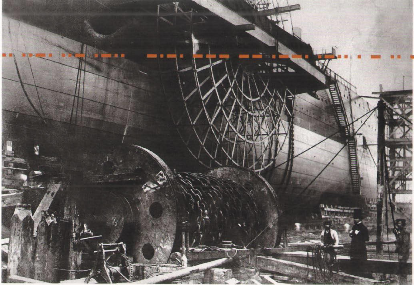
Die »Great Eastern« ist das größte Projekt des renommierten Ingenieurs Isambard Kingdom Brunel. Er steckt sein Vermögen in den Bau des Dampfers, der von Schaufelrädern und von einer Schiffsschraube angetrieben wird und mit sechs Masten versehen ist
