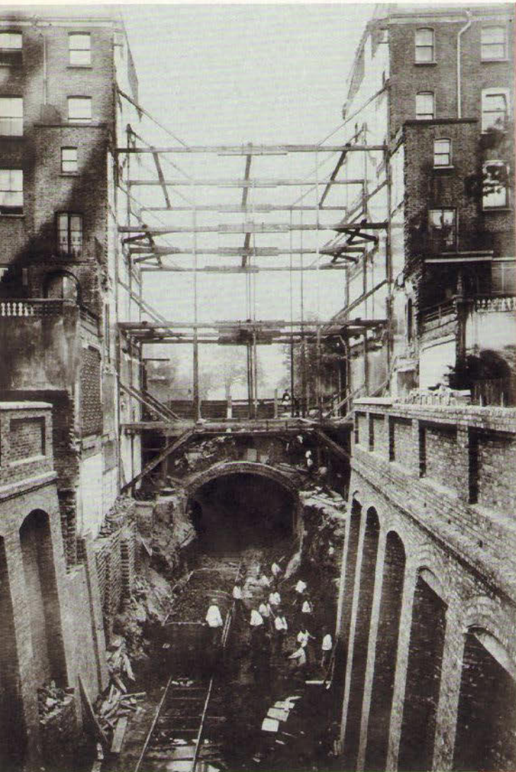
Ab 1860 schlugen Bauarbeiter für die U-Bahn Schienen durch die Stadt. Manchmal, wie hier in Leinster Gardens, müssen die Arbeiter Häuser niederreißen. Auch deshalb werden spätere Linien tiefer ins Erdreich gelegt: Untertage graben Männer der Central London Railway 1898 mithilfe einer speziellen Stahlvorrichtung (oben rechts) jenen Tunnel, der diesen Bahnen ihren Spitznamen verleiht: »Tube« – englisch für Röhre
