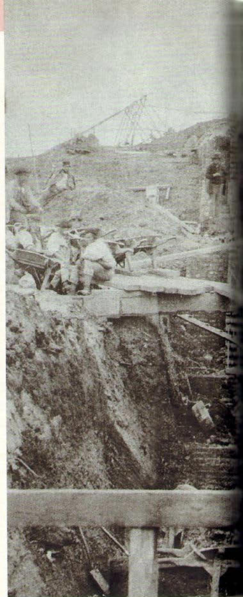
Mithilfe hölzerner Stützbögen mauern Arbeiter um 1860 einen gewaltigen Kanal, der die gesammelten Abwässer von Nord-London flussabwärts in die Themse leiten soll. Der Ausbau der Kanalisation ist neben der U-Bahn eines der dringendsten Bauprojekte. 1868 kann das neue System das Achtfache der damals anfallenden Abwassermenge aufnehmen. Doch nicht einmal 20 Jahre später ist es zu klein
