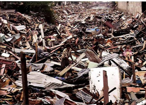
Viele Menschen entlang der tropischen Küsten des Indischen Ozeans, nicht nur die Ärmsten, haben ihre Häuser aus Wellblech und Holz errichtet: fragile Gebäude, die, wie in Banda Aceh, unter dem Druck des Wassers in Sekunden kollabieren
